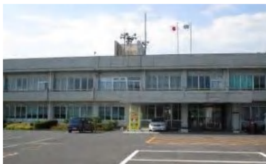
現 山之口総合支所
