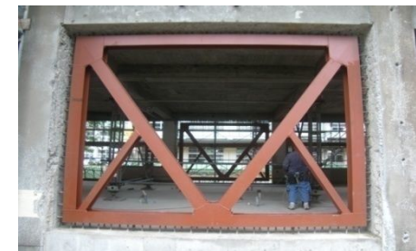
施工例: 姫城中補強
