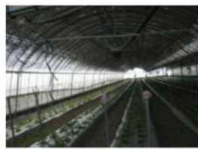
被覆施設への降灰の様子
