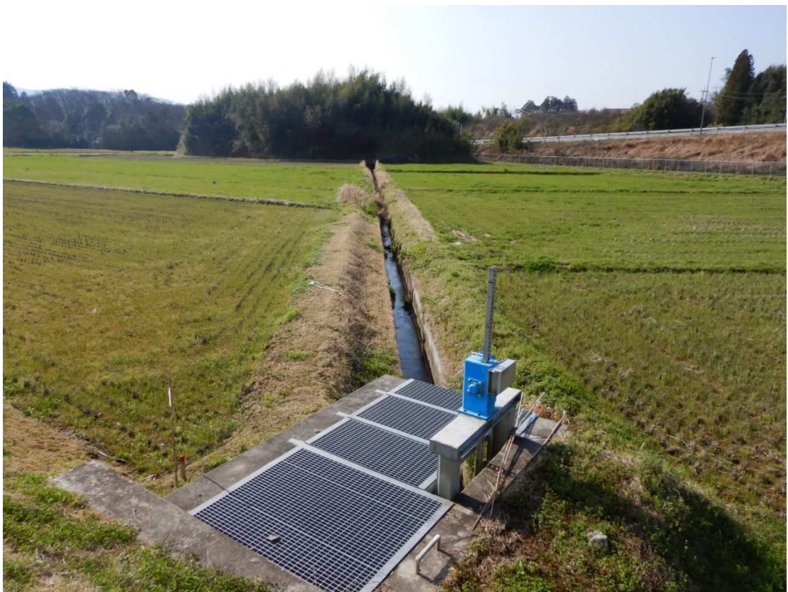
⑥2 工区の中間地点にある、深さ 1m 程度の水路
