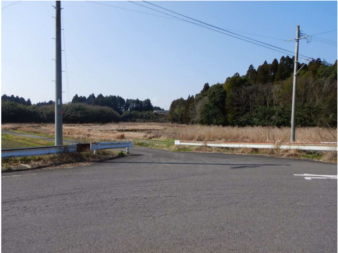
⑨4 工区全景
