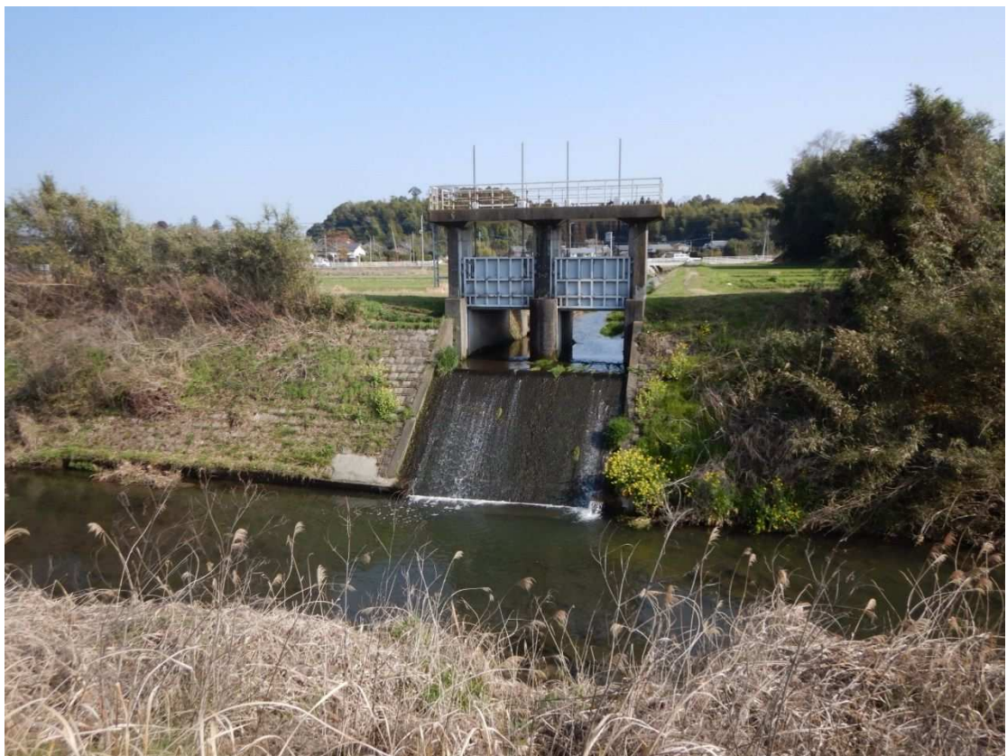
④野間川河口の水門
