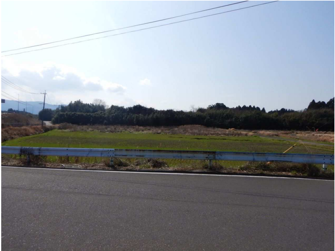
⑦3 工区全景
