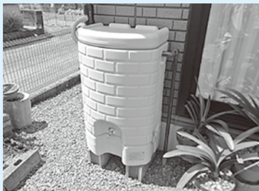
雨水タンク（200Lサイズ）の設置例
