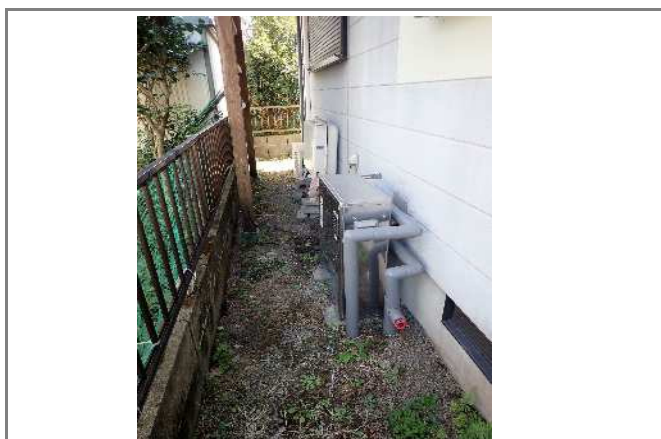
着工前: 既存給湯器 横方向
