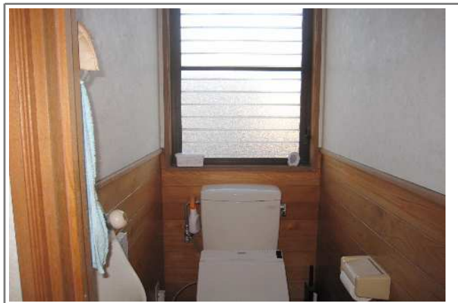
着工前:既存トイレ 正面部分
