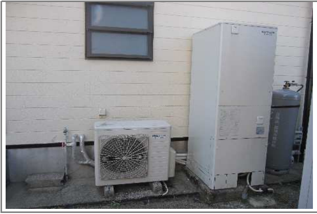
着工前:既存給湯器 全体
