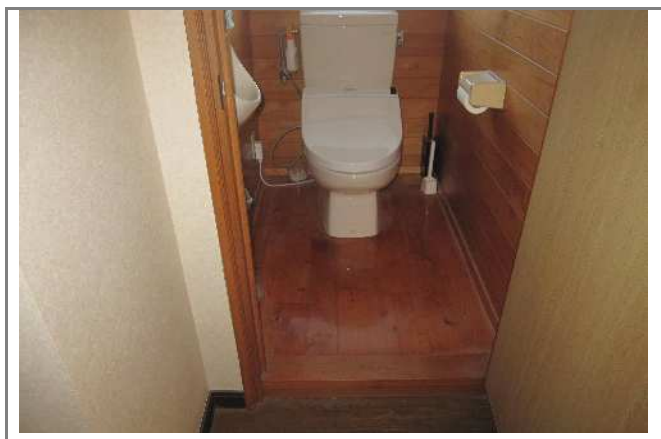
着工前:既存トイレ 入口及び床部分
