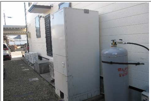
着工前:既存給湯器 横方向
