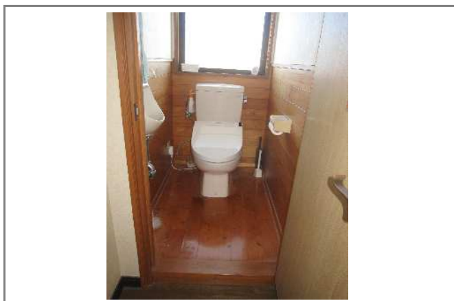
着工前:既存トイレ 全体
