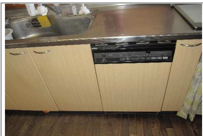
着工前:既存食洗器又は設置予定箇所の写真
