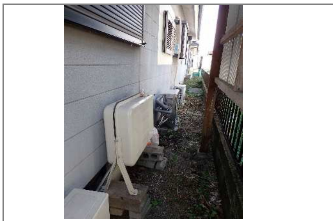
着工前: 既存給湯器 横方向
