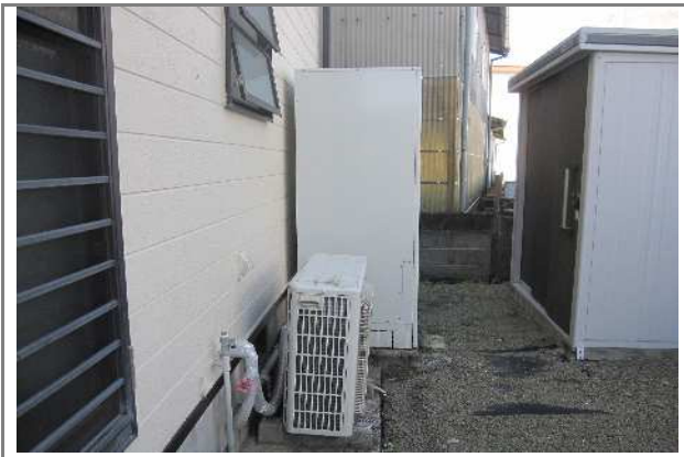
着工前:既存給湯器 横方向
