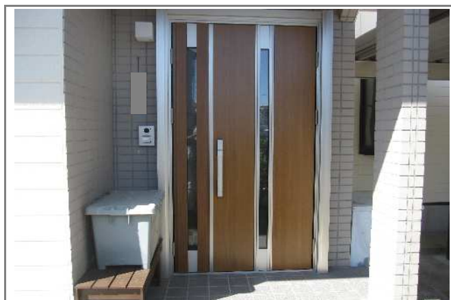
完成後: 玄関ドア取替 外側
