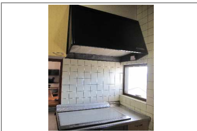
着工前:既存レンジフードの写真
