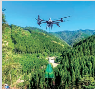
重機や車が入れない場所への資材運搬で活躍するドローン
