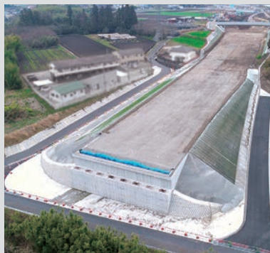
令和5年に宮崎河川国道事務所から表彰された都城志布志道路工事（乙房）
