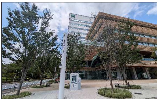
防災機能が強化された新千葉市役所
