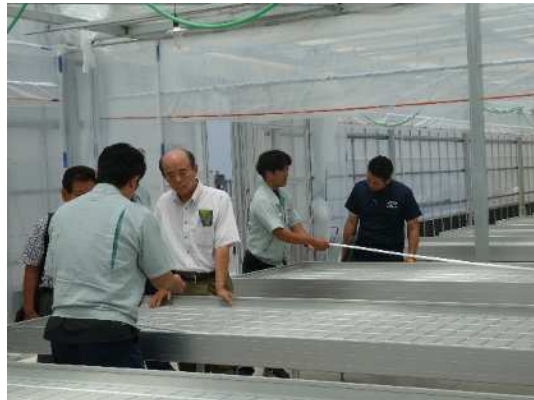
【育苗施設 機械化により人手を省いているほか 加温に志比田工場の温排水を利用している】
