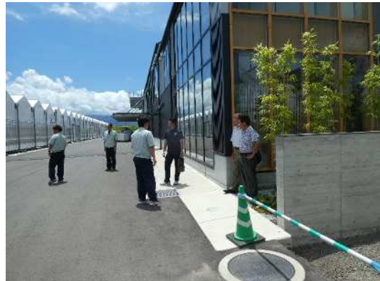
【管理研究棟（右側）と育苗施設（左側）】
