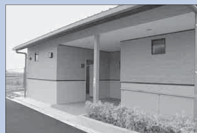
トイレは2個所に設置
