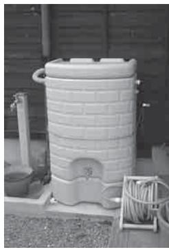
雨どい取り付け型の雨水貯留施設
