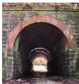
沿線で最も断面規模の大きい瀬久谷川暗渠（幅=4.58m、奥行き=38.6m）
