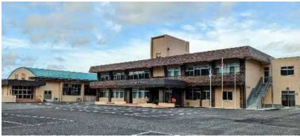
旧山之口地区公民館をリノベーションし、1Fに山之口総合支所、2Fに山之口総合センターを配置するとともに、旧勤労センターも多目的ホール(左奥)として一体的に複合化。地域コミュニティの場の確保と防災力強化を図る。
