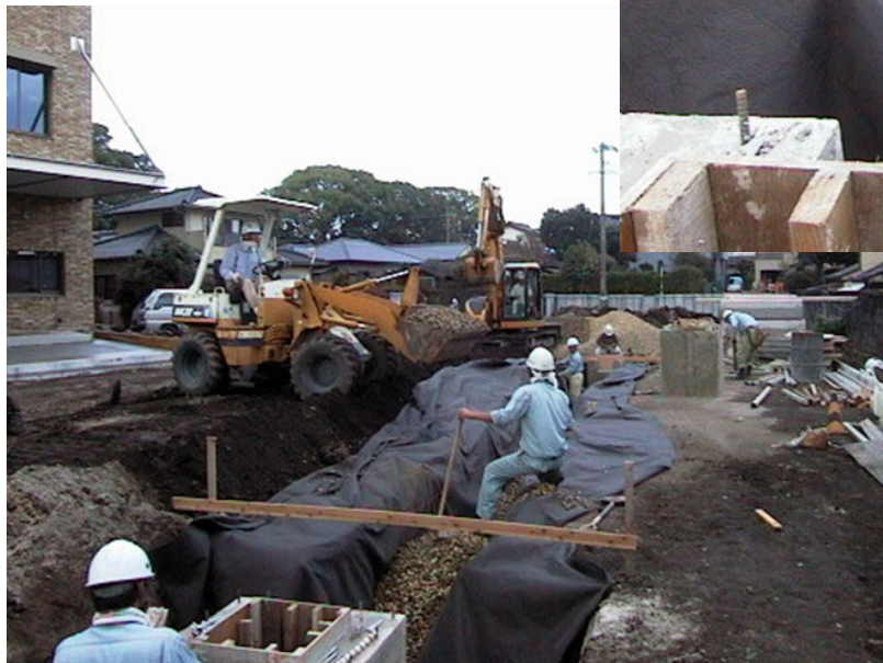
浸透トレンチの 布設
