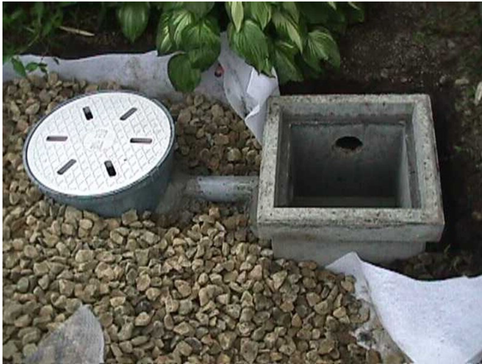
浸透ますの布設
