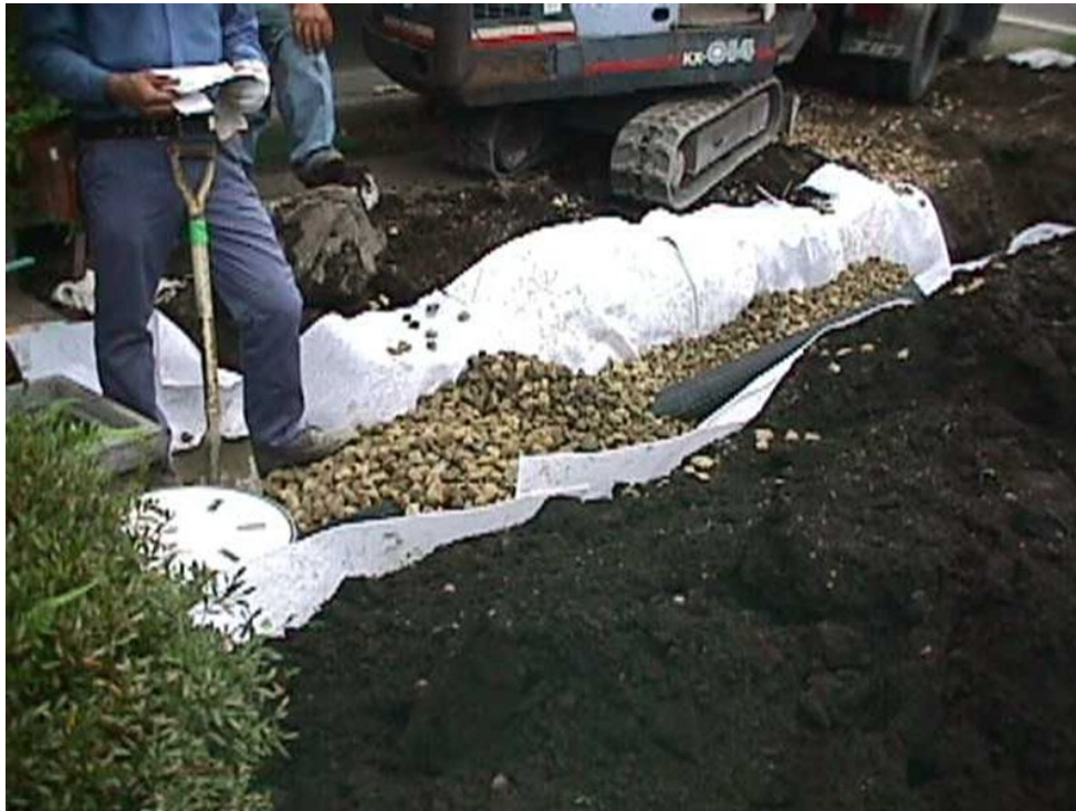
浸透トレンチの布設
