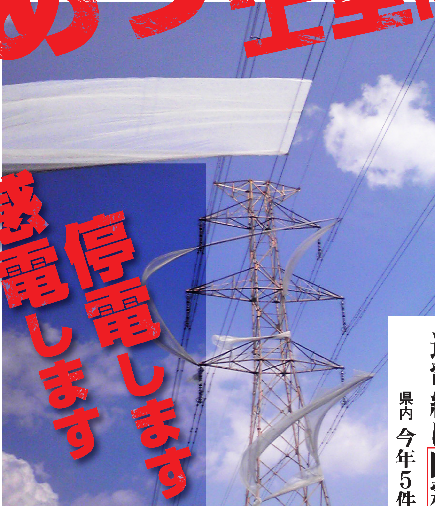
防霜シートが巻き付いた送電線（九州電力宮崎支社提供）
