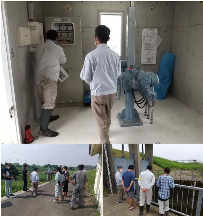
樋管総点検実施状況
