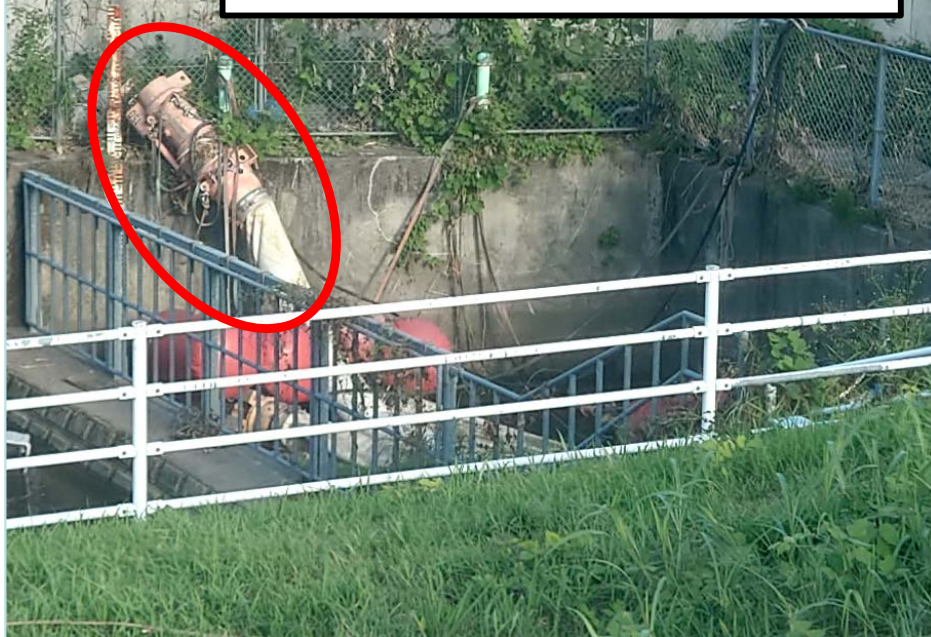
排水作業終了後、柵に引っかかったポンプ
