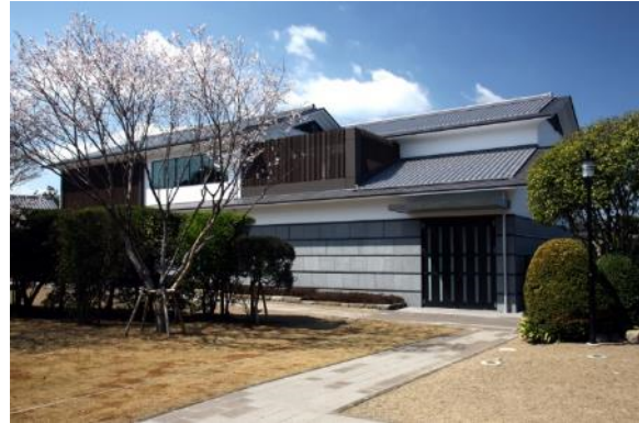
都城島津邸内にある都城島津伝承館
