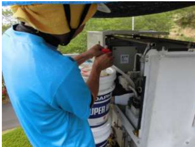
油圧緊張ユニット油交換
