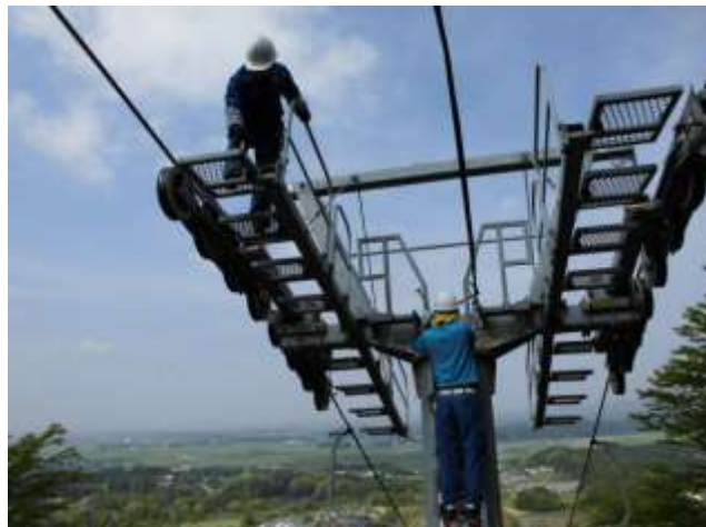
支柱打音検査
