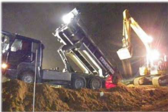
災害復旧工事の様子
