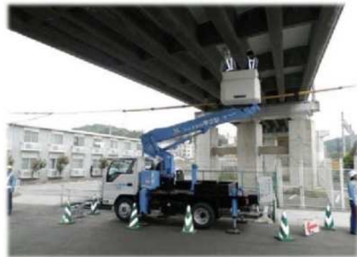
橋梁の定期点検
