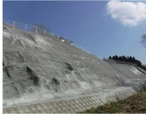
急傾斜地崩壊対策事業
