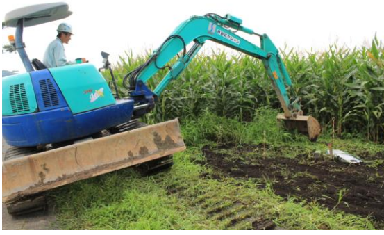
携帯電話中継基地局鉄塔の試掘現場
