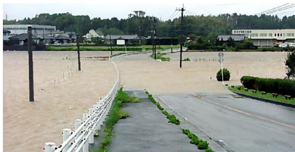
▲浸水被害の様子
