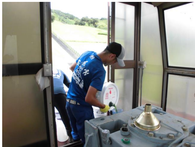
減速機オイル交換
