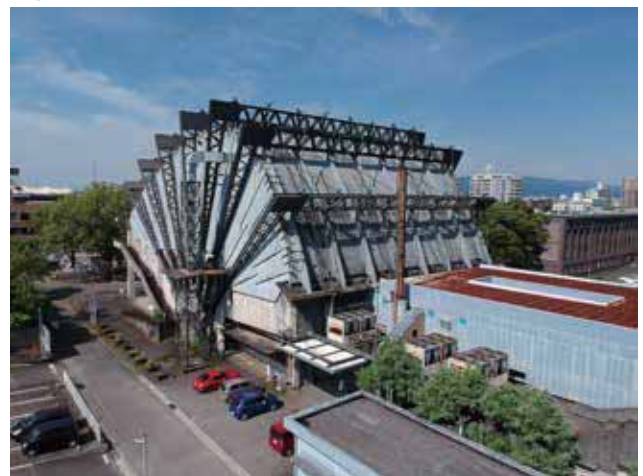
Fig3-1-4.2019年05月30日ドローンによる撮影
