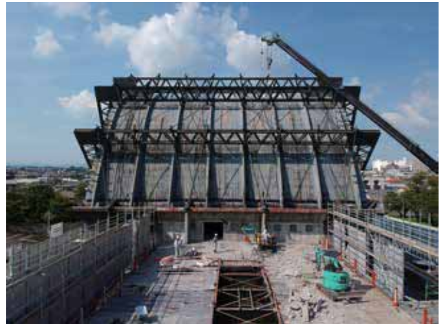
Fig3-1-11.2019年08月07日ドローンによる撮影
