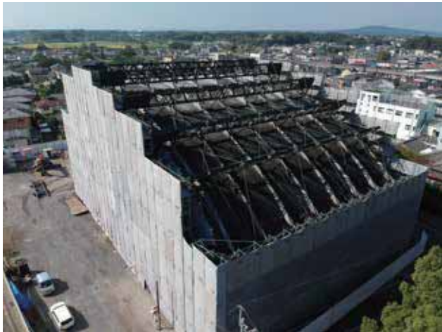
Fig3-1-20.2019年10月16日ドローンによる撮影
