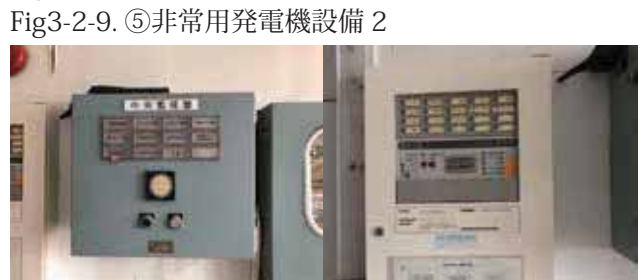
Fig3-2-8. ④非常用発電機設備 1
