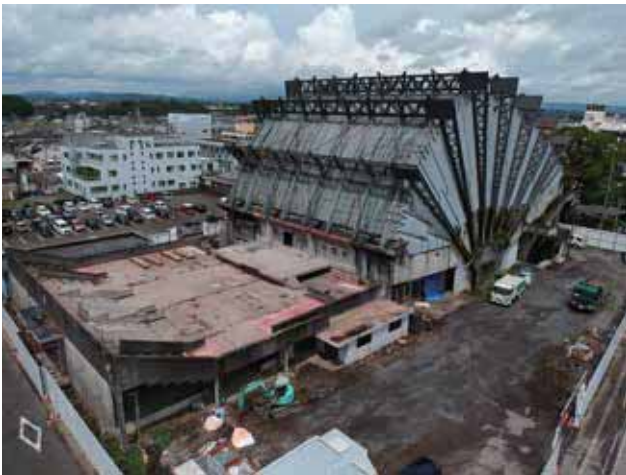
Fig3-1-12.2019年09月02日ドローンによる撮影
