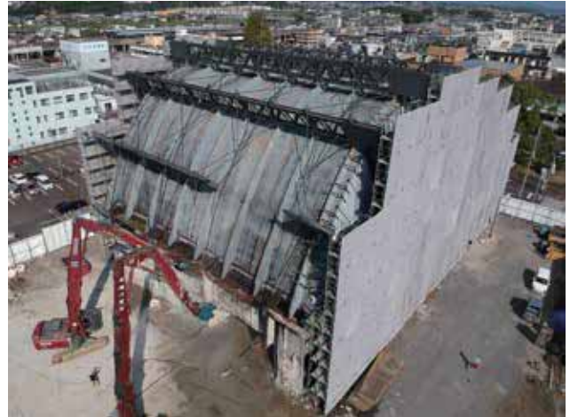
Fig3-1-17.2019年10月16日ドローンによる撮影
