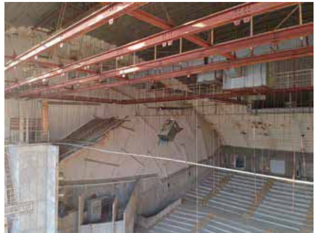
Fig3-1-22.2019年10月16日ドローンによる撮影
