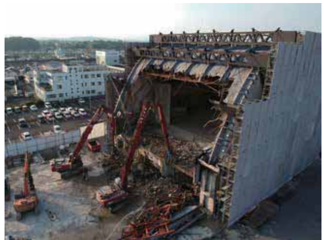
Fig3-1-21.2019年10月16日ドローンによる撮影
