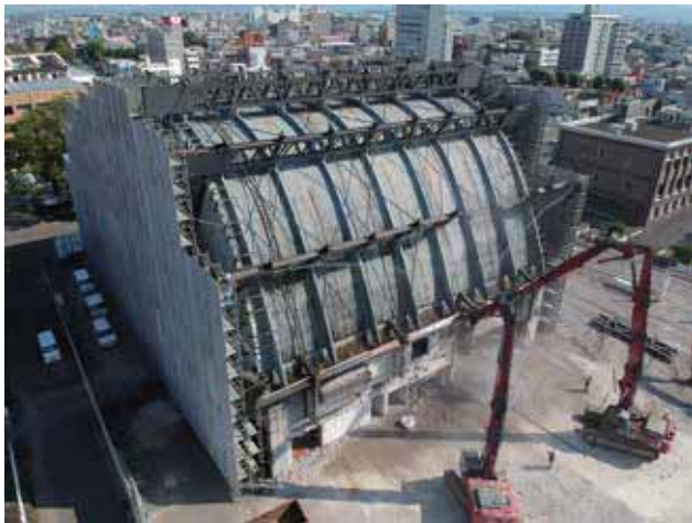
Fig3-1-18.2019年10月16日ドローンによる撮影
