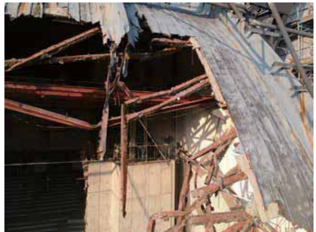
Fig3-1-23.2019年10月16日ドローンによる撮影
