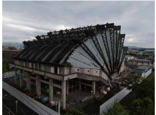
Fig3-1-16.2019年09月26日ドローンによる撮影
