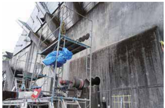
Fig3-1-42. 都城市民会館北側立面図解体調査の様子
