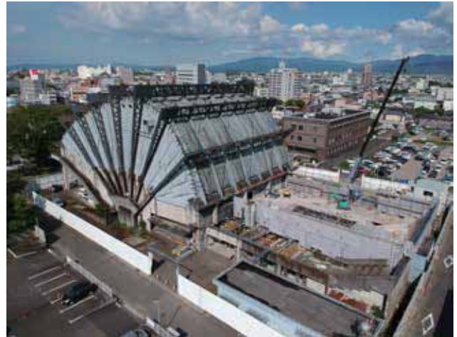
Fig3-1-10.2019年08月07日ドローンによる撮影
