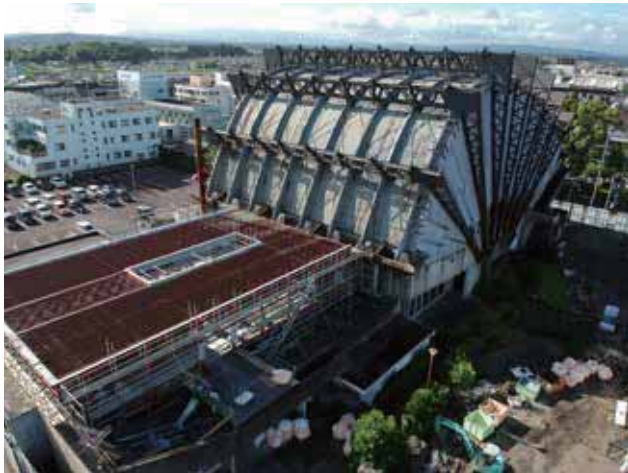
Fig3-1-8.2019年08月07日ドローンによる撮影
