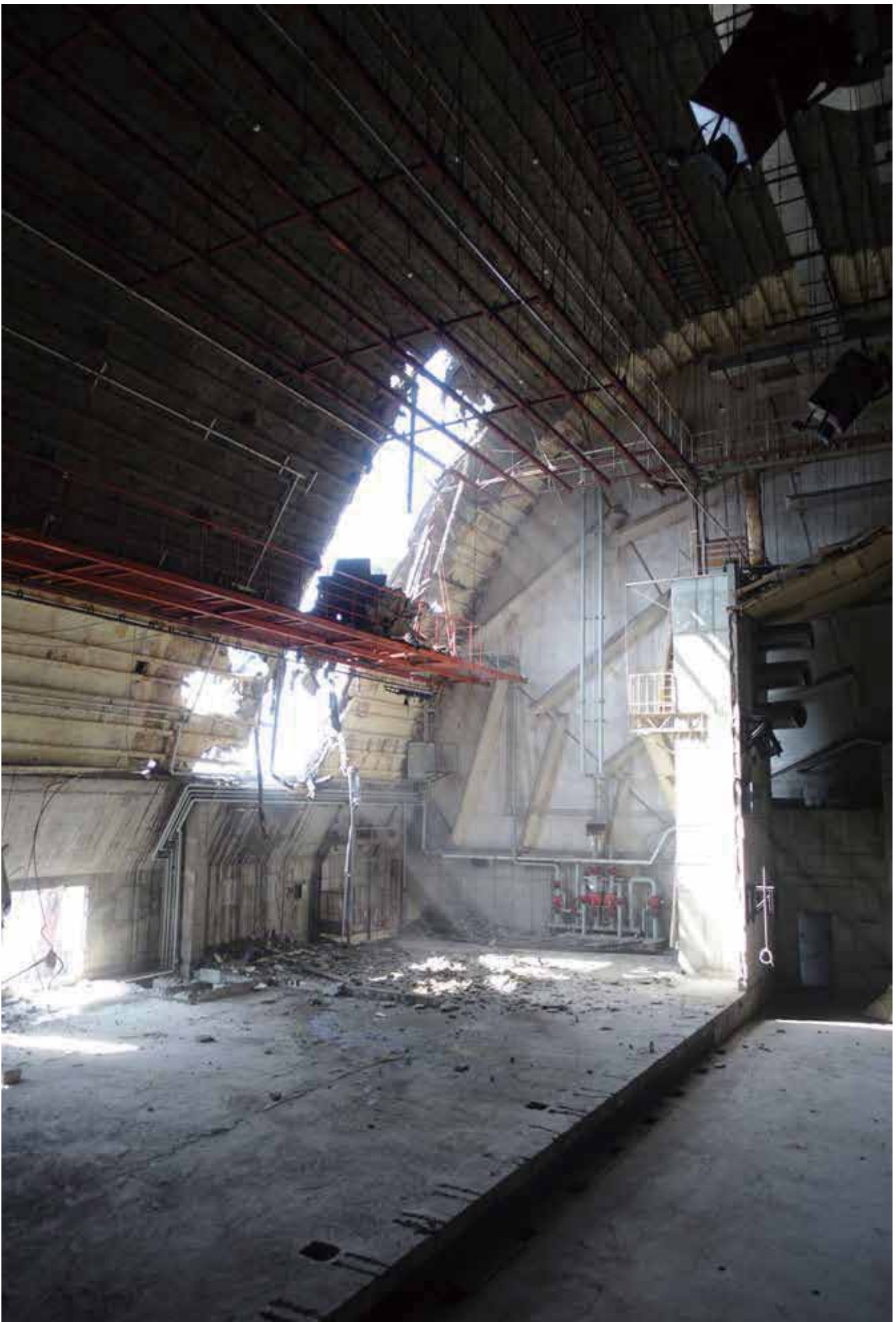
Fig3-0-1. 解体工事の様子 2019年10月16日
