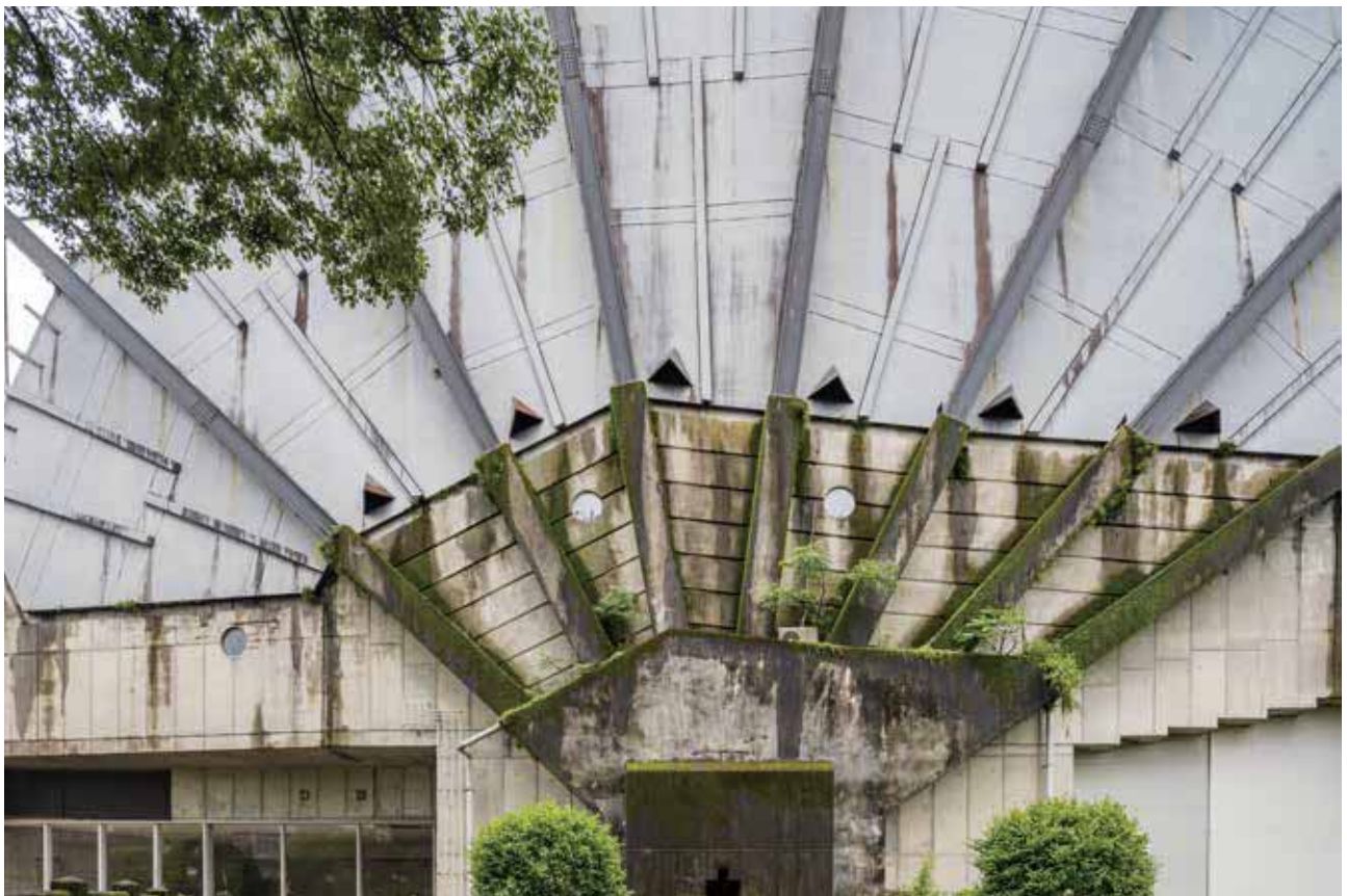
Fig.0-8. 東側架構集中部
