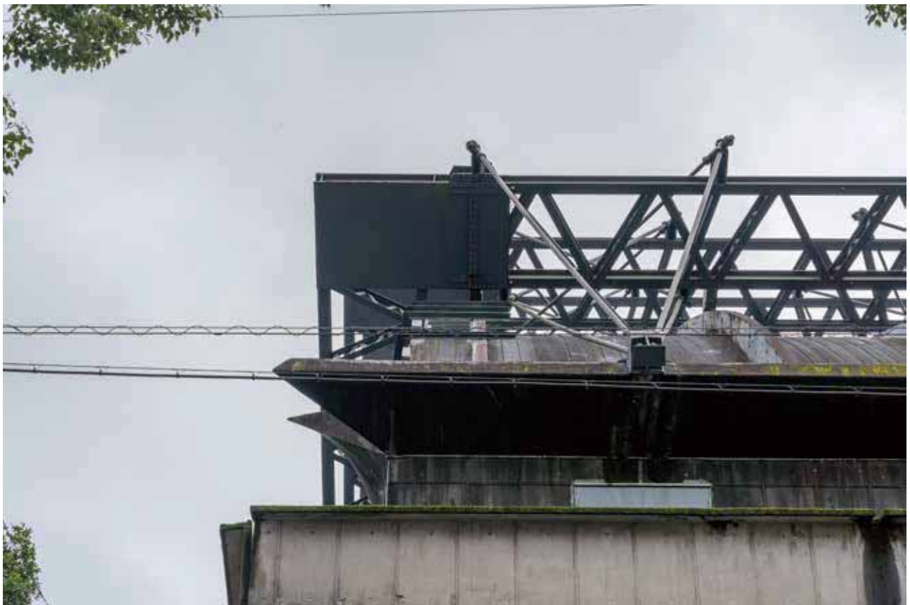
Fig.0-13. 架構一部外観
