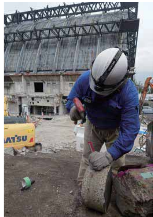
Fig3-1-43. 都城市民会館北側立面図解体調査の様子
