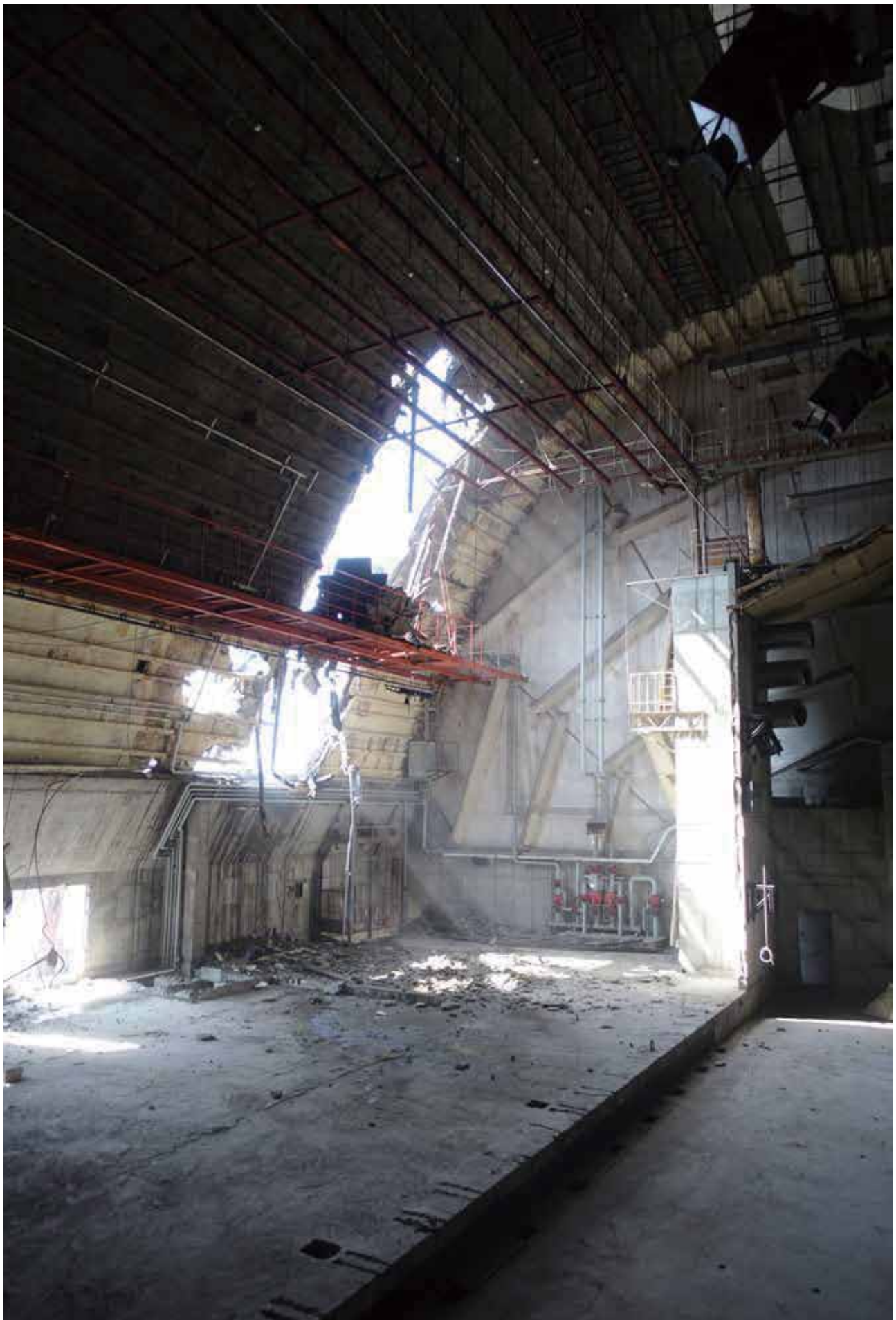
Fig3-0-1. 解体工事の様子 2019年10月16日
