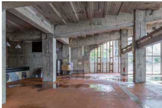
Fig3-3-2.2019年エントランスホール
