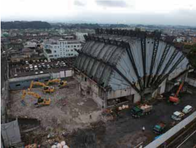
Fig3-1-14.2019年09月26日ドローンによる撮影
