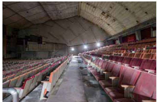
Fig3-3-7.2019年解体前のホール内部
