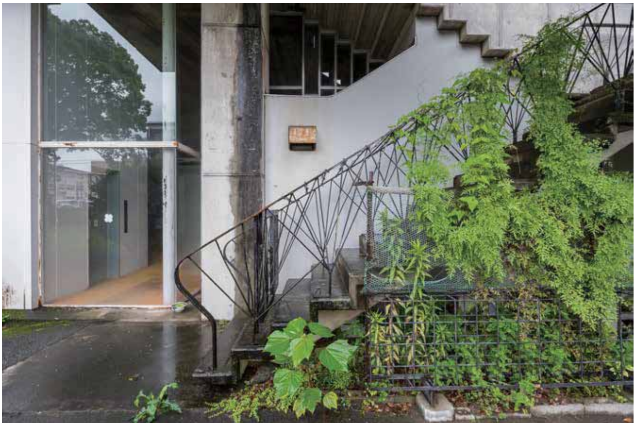
Fig.0-16. 東側屋外階段
