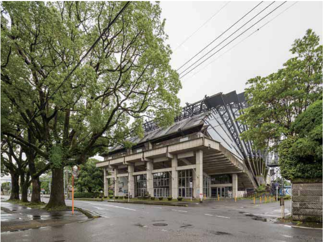
Fig.0-4.2019年解体前の旧都城市民会館の様子 北側からの風景
