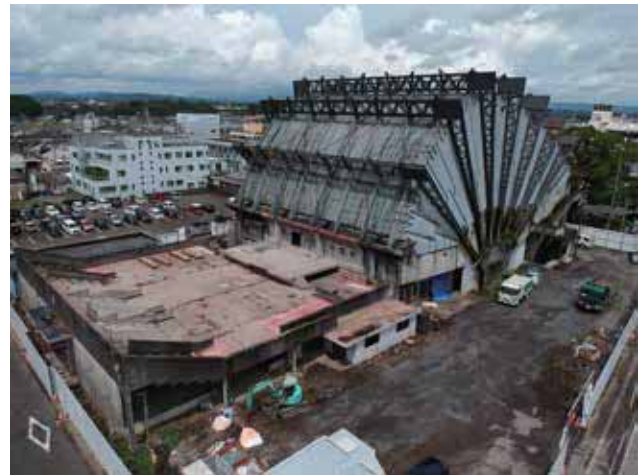
Fig.2-1-1.2019年9月2日解体の様子撮影斎藤信吾
