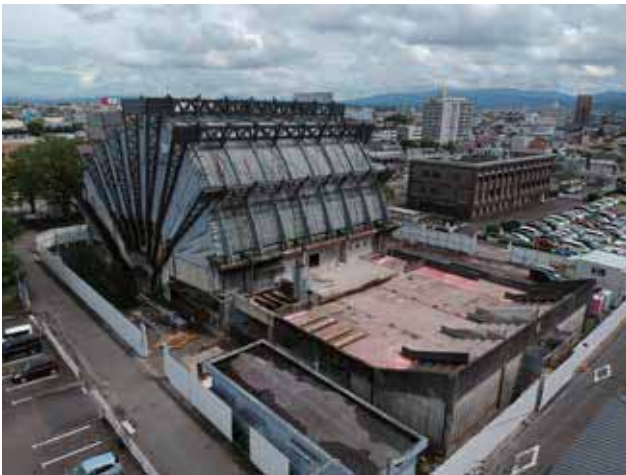
Fig3-1-13.2019年09月02日ドローンによる撮影
