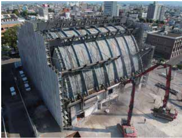
Fig3-1-18.2019年10月16日ドローンによる撮影
