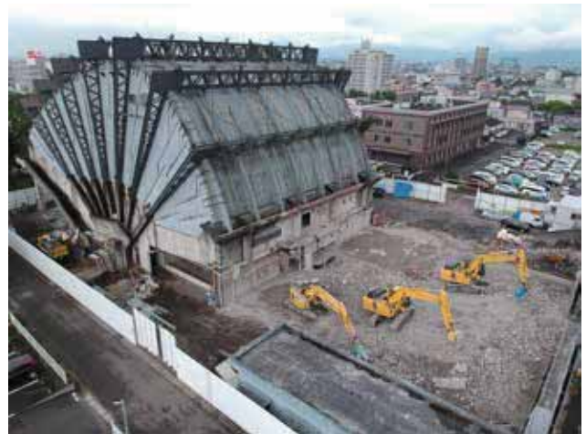
Fig3-1-15.2019年09月26日ドローンによる撮影
