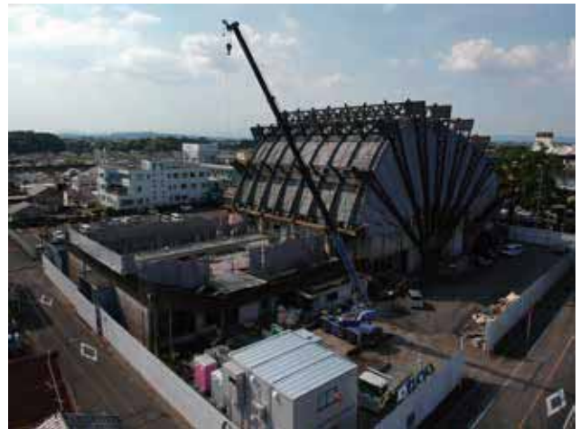
Fig3-1-9.2019年08月07日ドローンによる撮影
