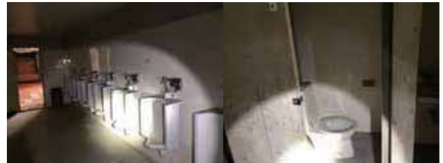
Fig3-2-25. ⑰小便器と洋風大便器 1
