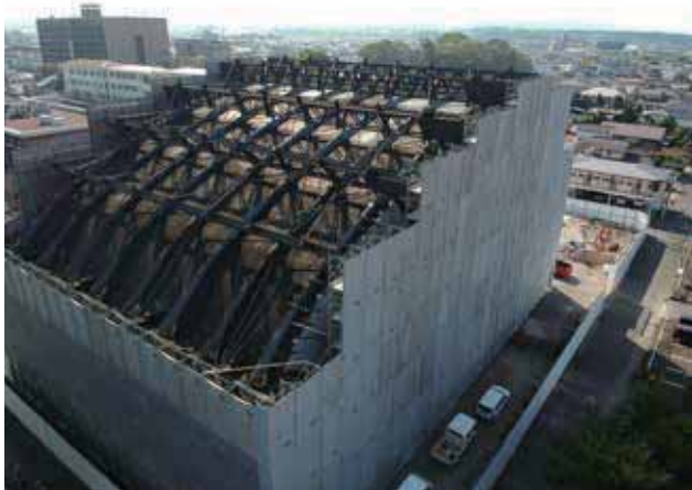
Fig3-1-19.2019年10月16日ドローンによる撮影
